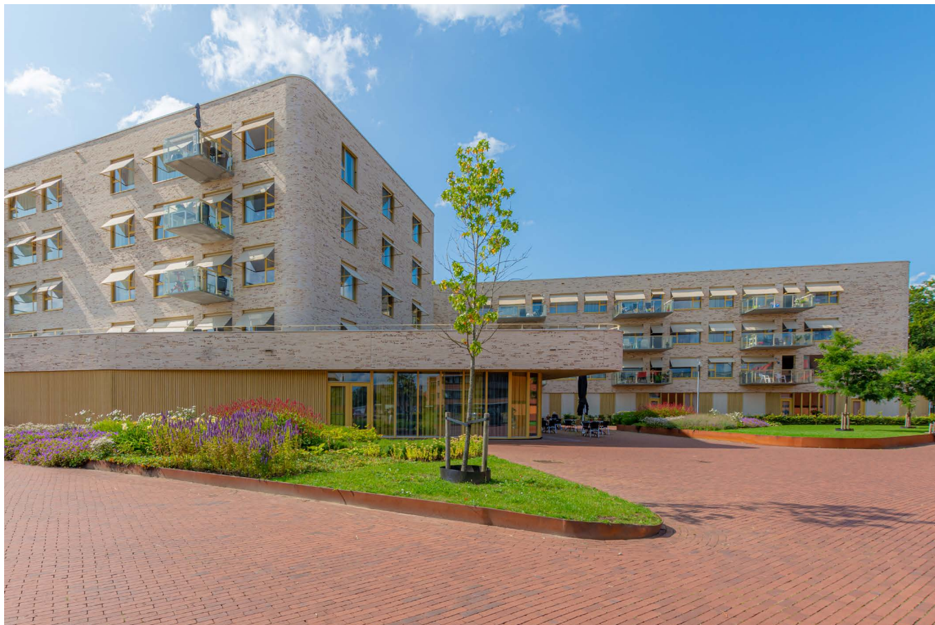
afbeelding 5. Verzachting door ronde hoeken en verdraaiing van de gebouwen.
